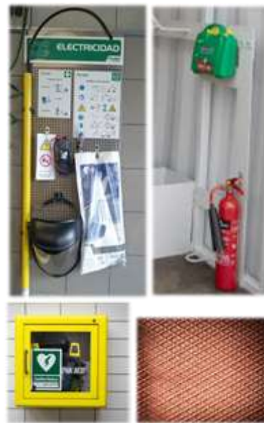
Figura 20. Material de actuación ante emergencias.
