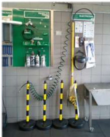
Figura 14. Panel del taller. Fuente: imágenes cedidas por Feu Vert Ibérica, S.A.
